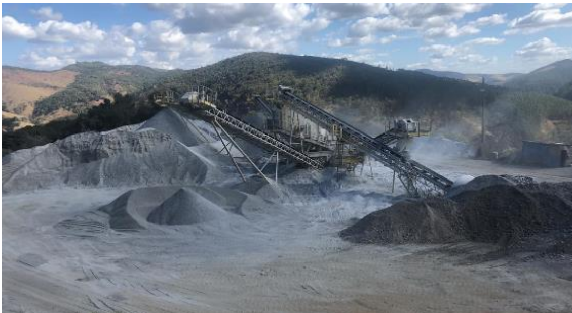
Foto 10: Vista panorâmica parcial da Britagem Móvel / Praça de Carregamento / Pilha de minério.
