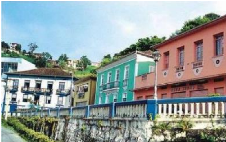
Figura 57: Paredão localizado na rua Tiradentes, no centro do município de Itabira/MG.
