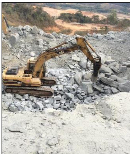
Foto 4: Martelo Montanbert acoplado a escavadeira Caterpillar 320.
